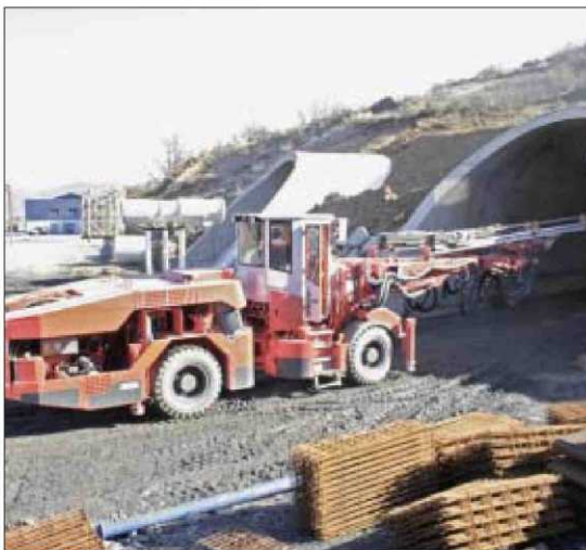
Una máquina pesada se dispone a entrar en un túnel.
